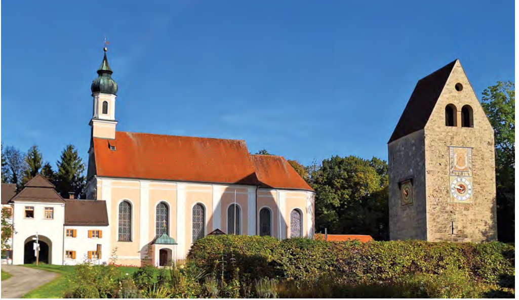
Pfarrkirche Wessobrunn mit Römerturm rechts
